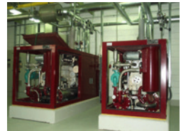
Blockheizkraftwerk (BHKW)
