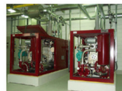
Blockheizkraftwerk (BHKW)
